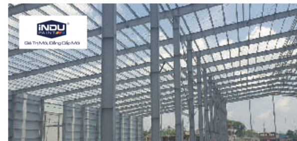
Dự án: NHÀ XƯỞNG SẢN XUẤT CTY PILMICO GROUP
