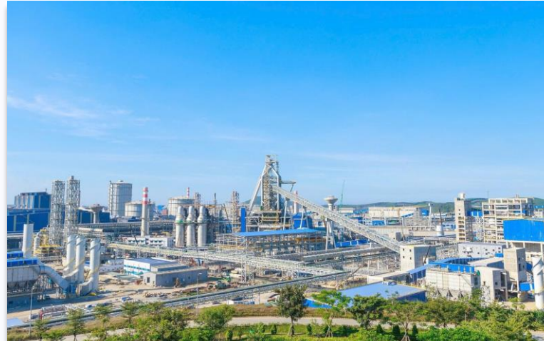
Nhà máy thép ray Hoà Phát Dung Quất CÔNG TY CỔ PHẦN TẬP ĐOÀN HOÀ PHÁT
