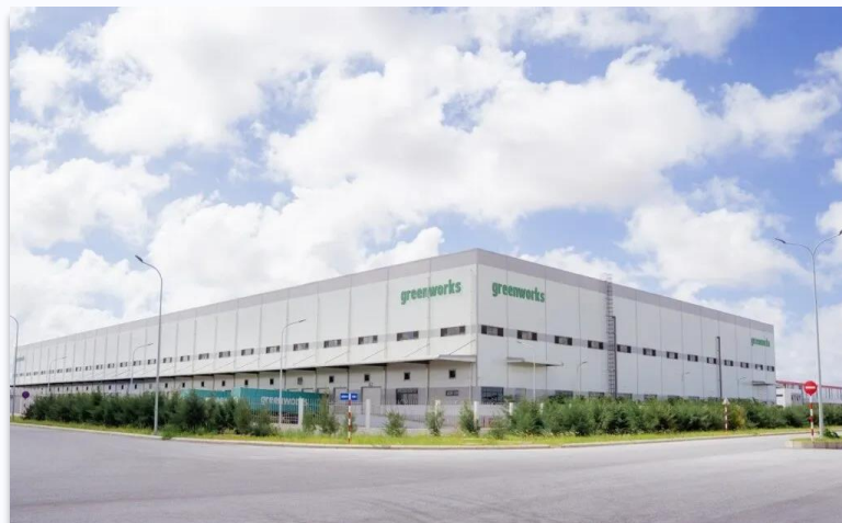
Nhà máy Greenworks Tools Thái Bình – Giai đoạn 2 GREENWORKS VIỆT NAM
